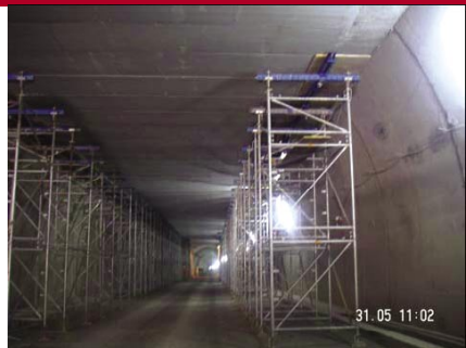
Posa in opera solai alveolari per cunicolo di ventilazione
