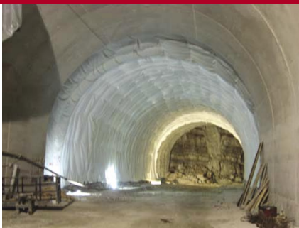
Galleria Scrajo 1 (impermeabilizzazione e rivestimento)
